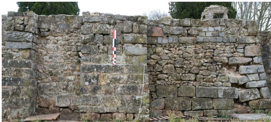
Figure 3 : Vue des parements au nord de la zone de la tour carrée © Centre André Chastel
