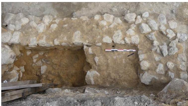
Figure 5 : Vue du mur MR48 et du sondage réalisé dans les maçonneries 1244 © E. Lombard
