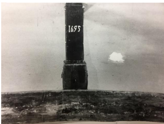
Nozay, détail de la charpente
