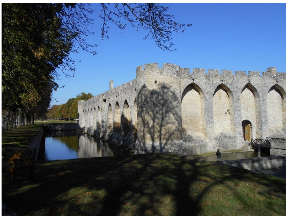
Murs et douves du château de Farcheville
