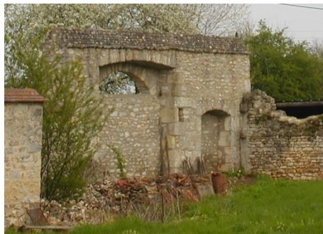
Le portail de la ferme des célestins à Ardenne (vu de l'intérieur)
