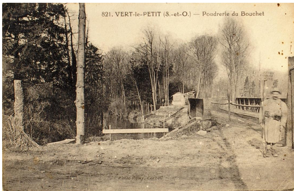
Carte postale « 821. VERT-le-PETIT (S.-et-O.) - Poudrerie du Bouchet, Photo Remy, Corbeil » montrant la garde du pont de chemin de fer sur l'Esnonne - Collection privée
