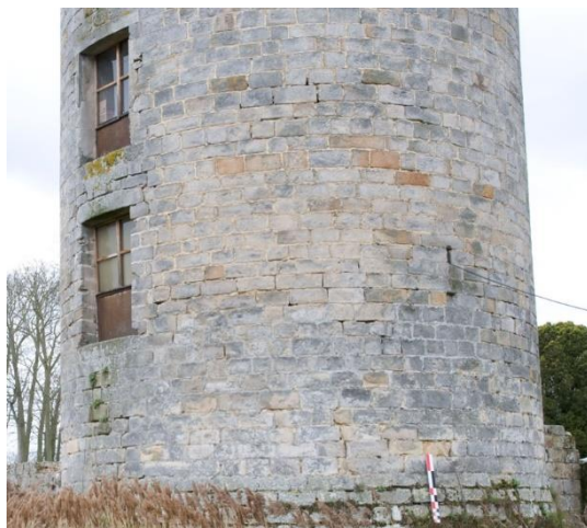
Figure 2 : Vue de l'élévation de la tour Henri IV : exemple de l'appareil du XV e siècle © Centre André Chastel
